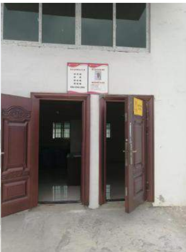
医疗废物暂存间
